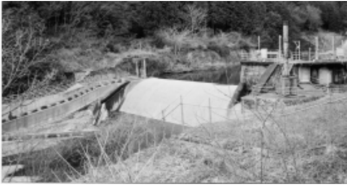
小さな支流にも取水堰が 左に見えるのが魚道
