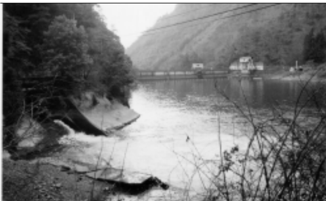
巨大な発電用調整池 宇賀ダム湖 左に導水管から水が流れ込んでいる
