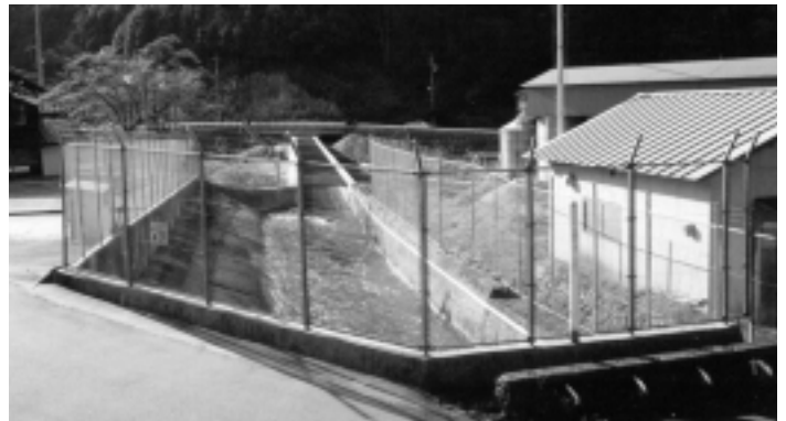
発電用導水路
