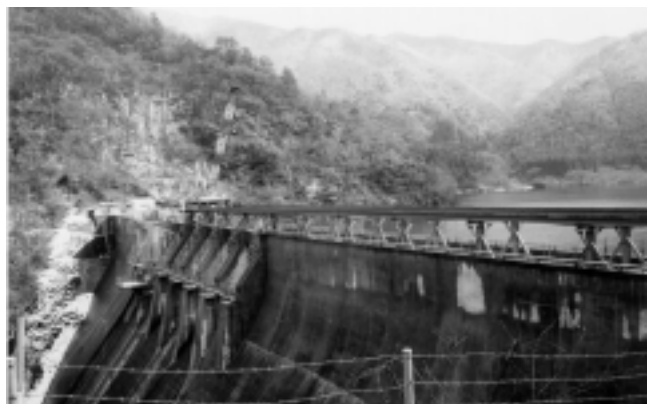
建設から60年を超える立岩ダム
