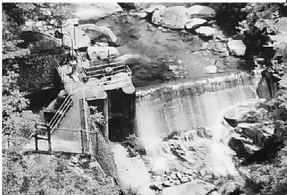
内隠取水堰 国道186号線の滝見橋からよく見える
