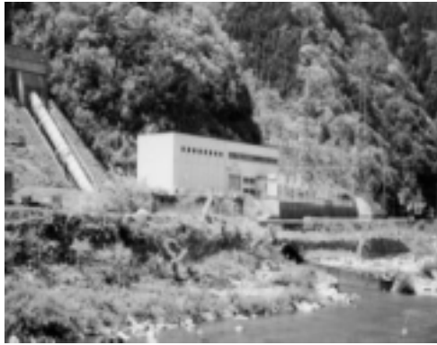
間の平発電所
