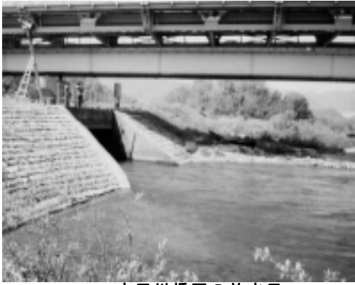
太田川橋下の放水口
